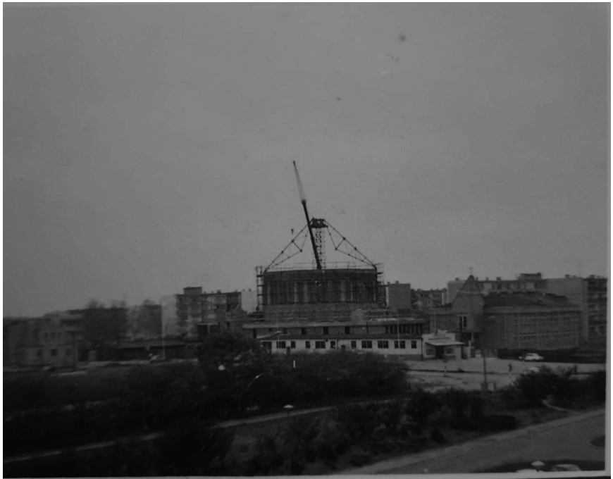
Fot. 20. Początek montażu stalowej konstrukcji kopuły kościoła pw Bł. Radzyna Gaudentego. Fot.: Romuald Nowak. Zdjęcie wykonano 4.04.1991 r. Ze zbiorów Agnieszki Alejskiej.
