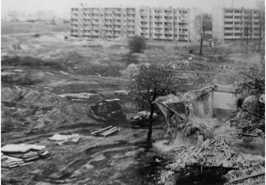
Fot. 16. Rozbórka domu Jana Osiki. W głębi widoczne bloki na Osiedlu Władysława Łokietka. Autor fot. nieznany. Zdjęcie wykonane na przełomie lat 1984 – 1985; https://www.facebook.com/groups/2483898861882179 ; dostęp w dniu 16.11.2021 r.
