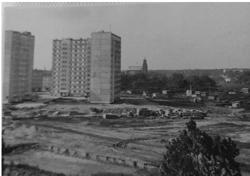
Fot. 19. Plac przygotowany pod budowę Szkoły Podstawowej nr 12 na Osiedlu Kazimierza Wielkiego. Po lewej stronie widoczne bloki Osiedla Władysława Łokietka. Autor fot. nieznany. Zdjęcie wykonane w 1984 r.; https://www.facebook.com/groups/2483898861882179 ; dostęp w dniu 16.11.2021 r.
