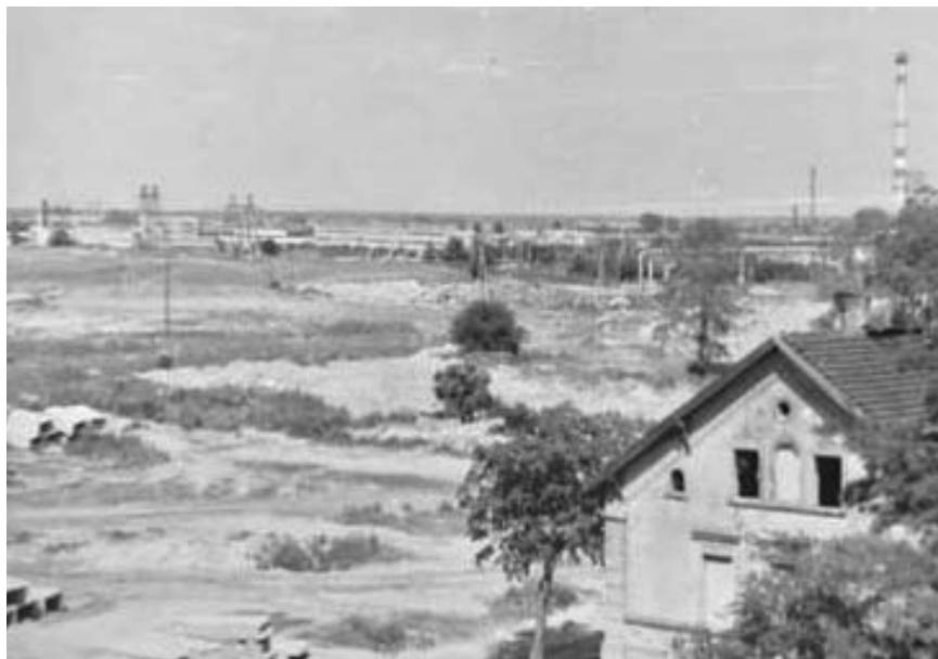
Fot.15. Dom Jana Osiki w miejscu przyszłego Osiedla Kazimierza Wielkiego. W głębi widoczny komin PEC. Autor fot. nieznan. Zdjęcie wykonano najpóźniej w 1984 r.; https://www.facebook.com/groups/2483898861882179 ; dostęp w dniu 16.11.2021 r.
