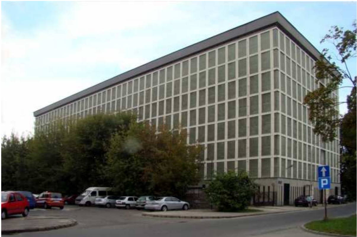
Budynek magazynowy Archiwum Akt Nowych w Warszawie (fot. Szczepeszynski, opublikowano na licencji Creative Commons Attribution-Share Alike 3.0 Unported ).
