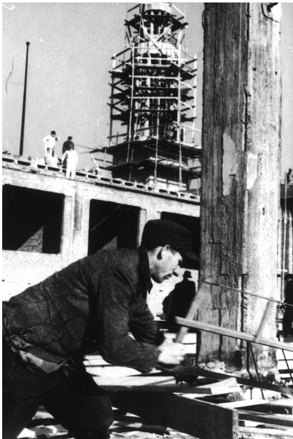
Ilustracja 15. Budowa nowej hali na terenach wystawowych Międzynarodowych Targów Poznańskich
