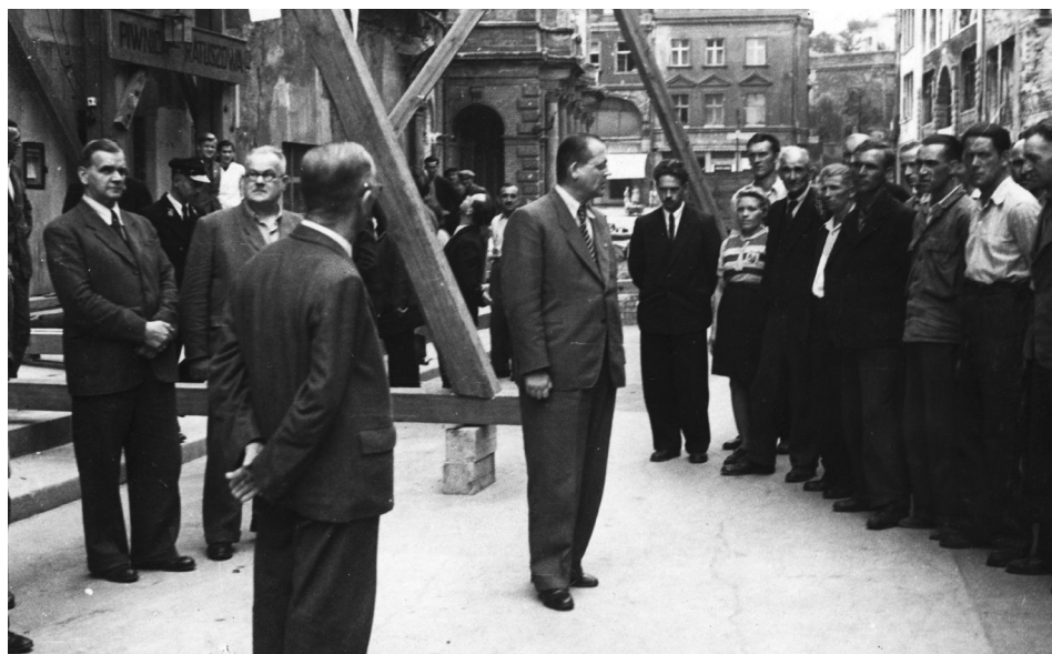
Ilustracja 13. Przedstawiciele Zarządu Miejskiego stołecznego miasta Poznania wśród robotników budowlanych pracujących przy odbudowie Ratusza ze zniszczeń wojennych
