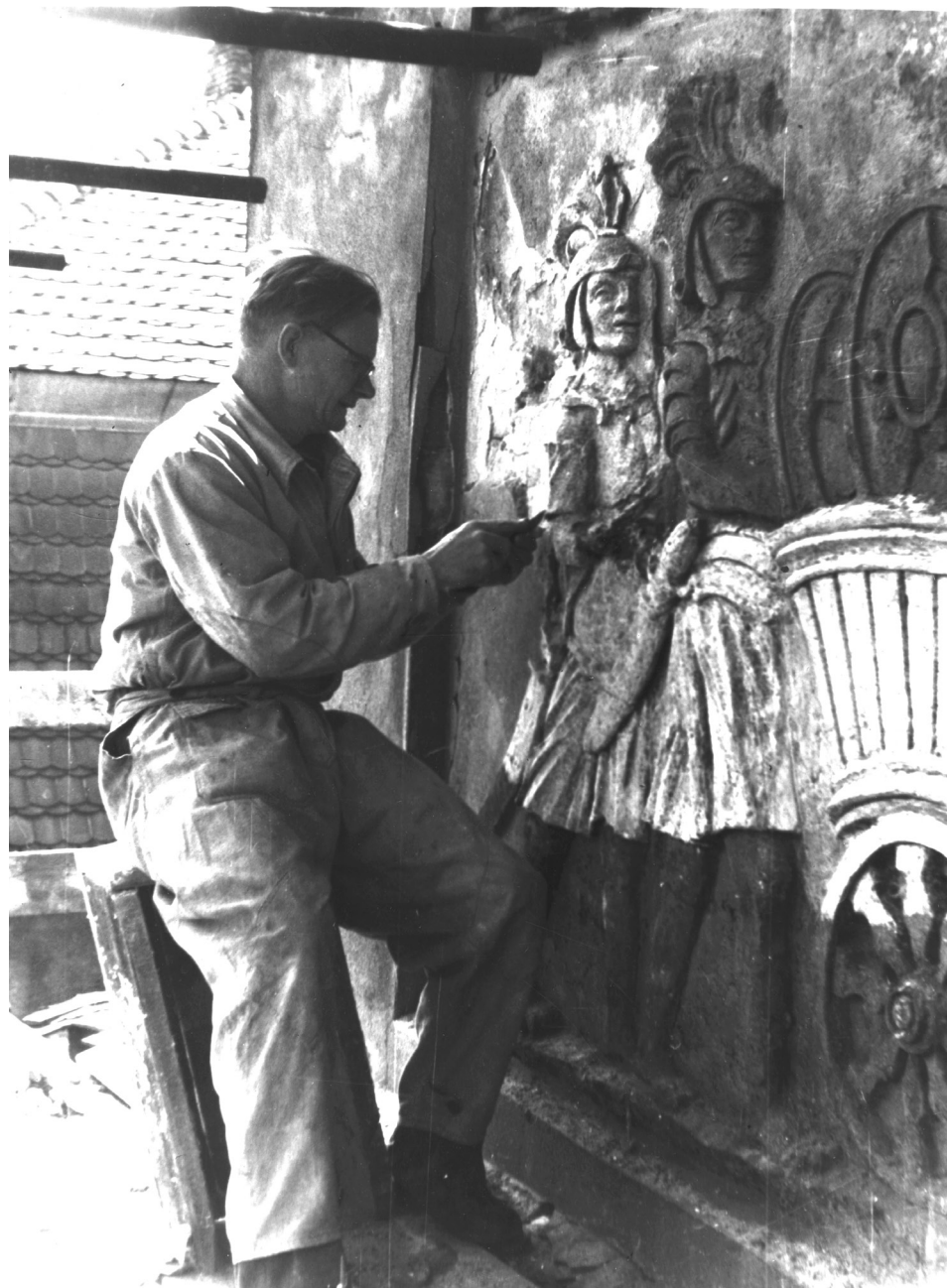
Ilustracja 24. Prace konserwacyjne płaskorzeźb na fasadzie pałacu Działyńskich na Starym Rynku
