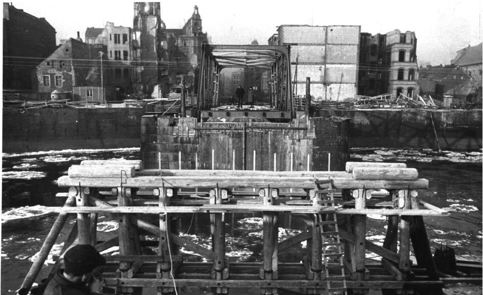
Ilustracja 17. Odbudowa zniszczonego w czasie drugiej wojny światowej mostu Chwaliszewskiego
