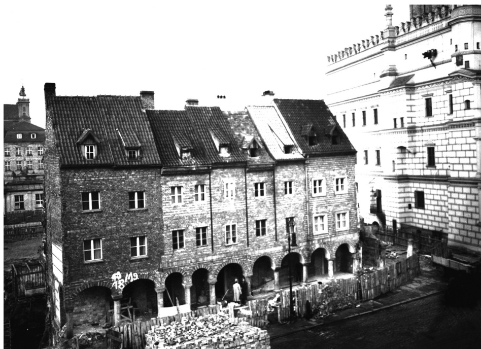
Ilustracja 27. Odbudowane ze zniszczeń wojennych domki budnicze w zabudowie wewnętrznej Starego Rynku
