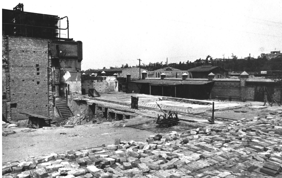
Ilustracja 8. Powojenna odbudowa rzeźni miejskiej
